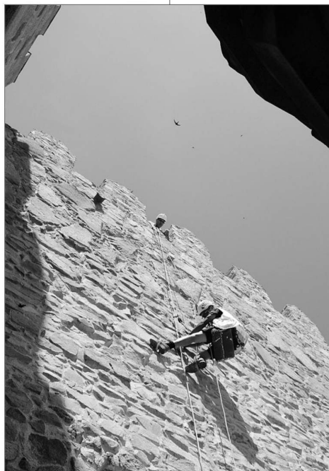
Técnico instalando sensores en la muralla abulense.
